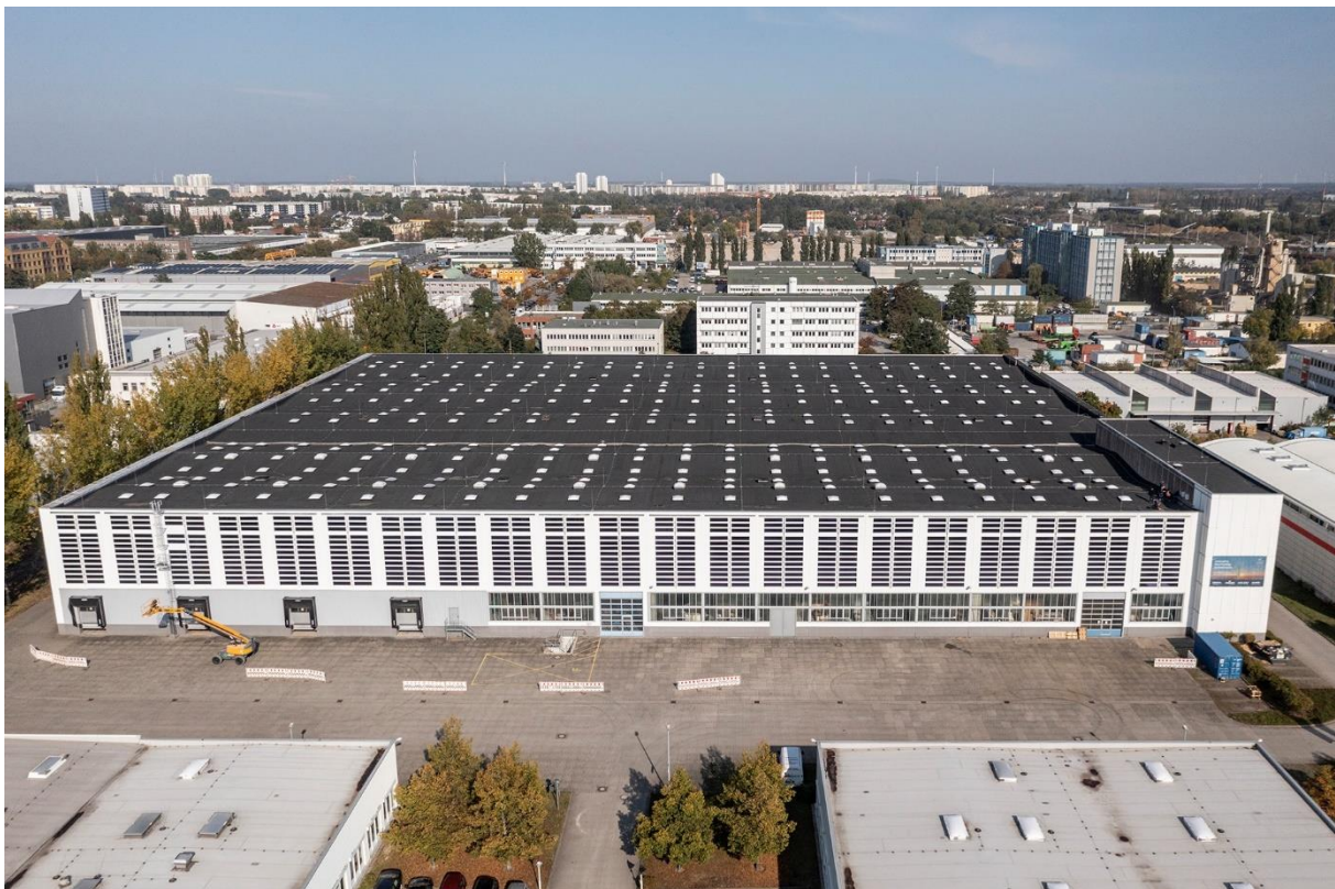
Bild 2: Die Bestandsimmobilie von GARBE in der Marzahner Straße in Berlin mit den integrierten HeliaSol ® Solarfolien.
