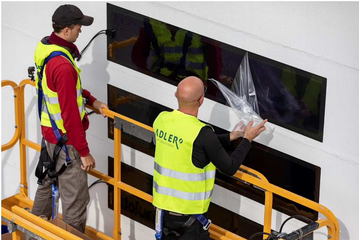
Bild 3: Mithilfe des integrierten Rückseitenklebers können die Die HeliSol ® Solarfolien präzise vom Montageteam angebracht werden.
